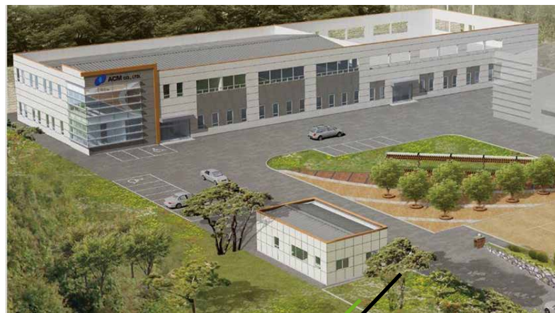
ACM 구미공장 신축공사
